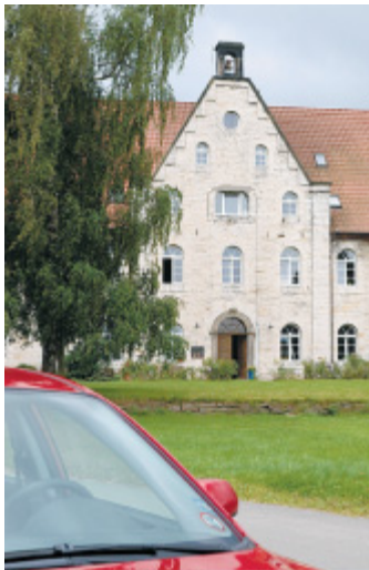
Laurentiushof: Hier wird unterrichtet, bis der Neubau fertig ist.
